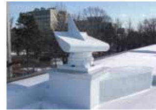
① 北海道札幌市 (大学実験棟) ※北海道大学工学部実験棟
