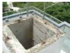
④ 旧ウイングジェットター取り外し
