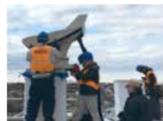
⑦ ウイングジェットター設置
