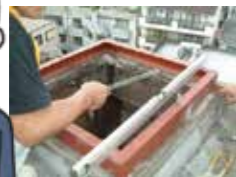
⑥ 取付架台をボルトへセット
