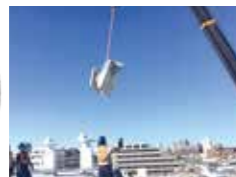
① 重機による荷上げ
