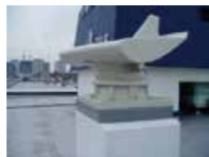
⑩ ウレタン塗布防水、取付完了
