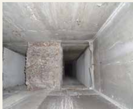
ウイングジェット 設置後30年経過後 の集合縦ダクト内部 非常にきれいなダクト内面で、内部臭気が適切に吸い上げられ、排出されていたことを示します。
